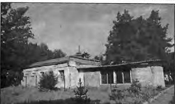
Строители треста «Мособлстрой» № 11 очень стараются подготовить здание к зиме.
