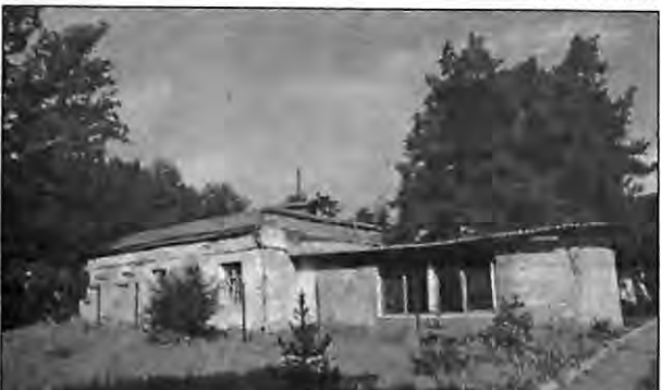
Строители треста «Мособлстрой» № 11 очень стараются подготовить здание к зиме.
